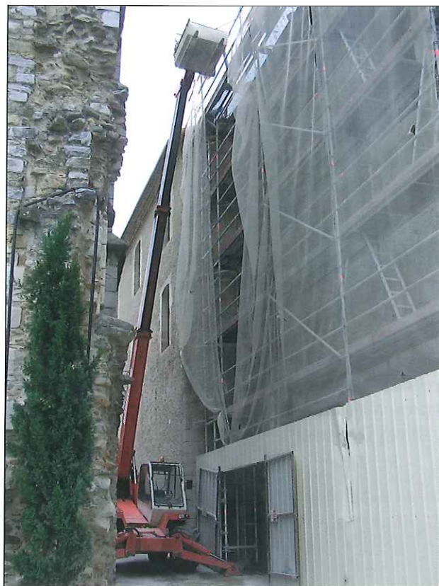
Travaux pour l'accès au Centre de Formation
