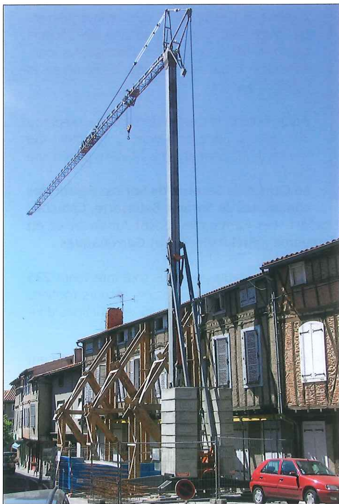
Travaux de la Maison d'Accueil, façade Sainte-Croix Rue Lacordaire
