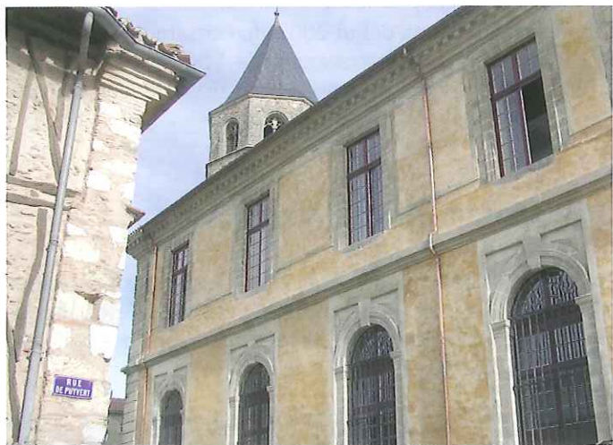
Aile Saint Martin rénovée
