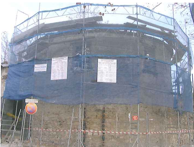
Les travaux ont bien avancé à la Tour Ronde
