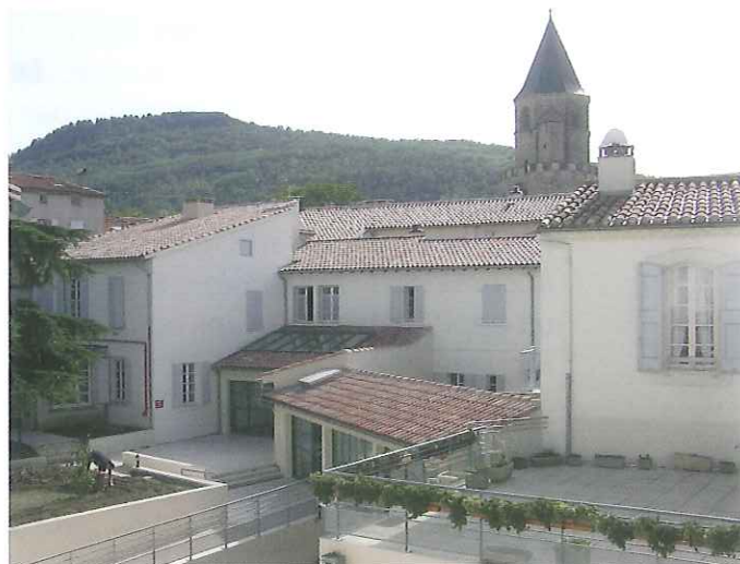
Bâtiments rénovés de la partie Saint Croix
