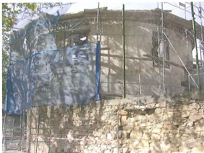
La Tour Ronde en travaux
