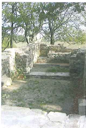
Résultat des travaux à l'automne
