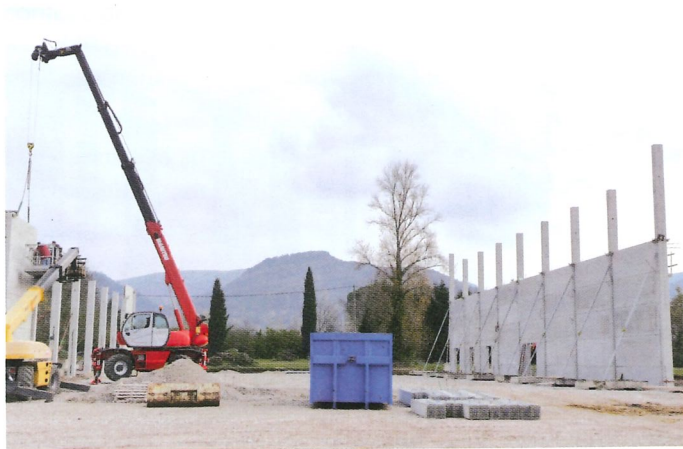
Construction en cours du centre sportif
