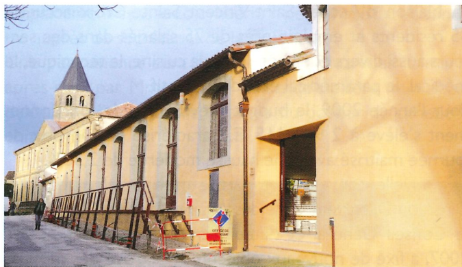
Façade de l'aile des « Bleus » rue Saint-Martin
