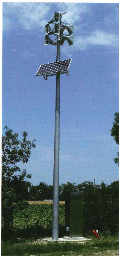
Le mat de sirène situé aux Moureaux à Sorèze a été modifié
