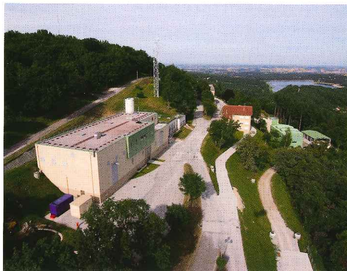
L'usine de Picotalen 3 s'intègre parfaitement dans un site remarquable au-dessus de Sorèze.
