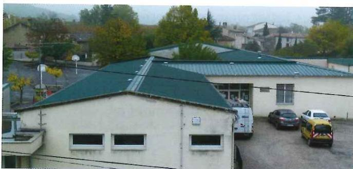
**Côté investissement**, c'est la toiture en éverite de la partie ancienne des bâtiments qui a été remplacée par une couverture en bac acier double-peau, identique au reste du groupe scolaire.
